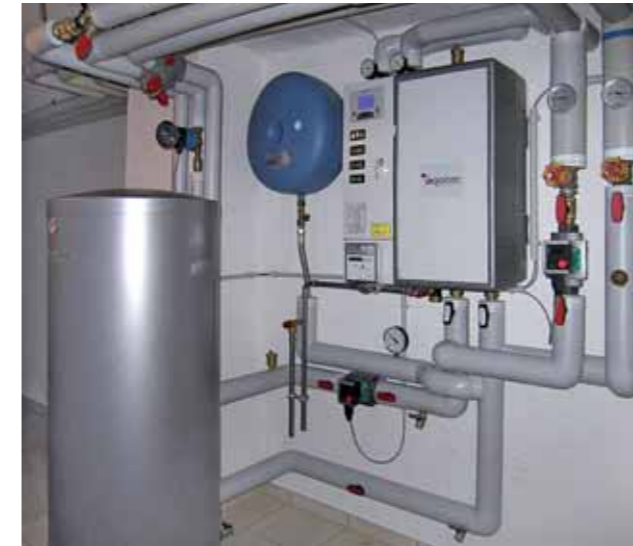
Beispiel einer Übergabestation für Einfamilienhäuser und Doppelhaushälften
